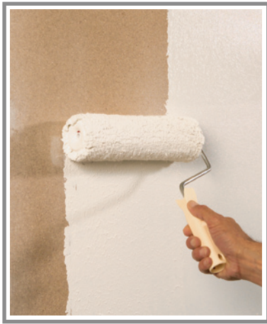
ambiente® Isoliergrund zweischichtig mit einer Lammfellrolle auftragen
