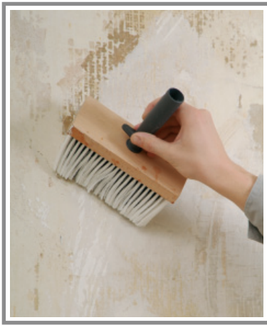
ambiente® Tiefengrund wird mit Quast, Rolle oder Pinsel in den Untergrund eingearbeitet
