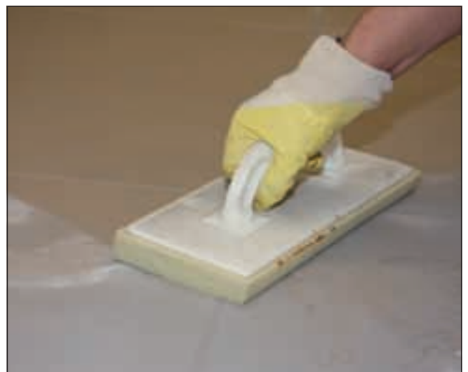
6 Abwaschen des Fliesenbelags nach ausreichender Standzeit der eingefugten Sopro Fugenmasse.
