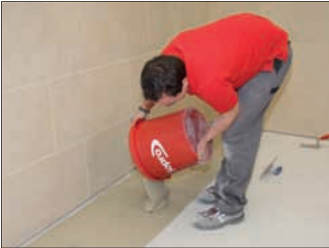
1 Ausgießen des Sopro FKM XL in Fließbettkonsistenz auf die vorbereitete Kontaktschicht.
