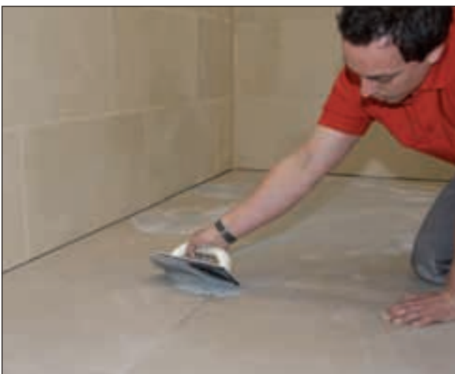
5 Verfugung der Fläche mit einer Sopro Fugenmasse (z. B. Sopro Brillant® PerlFuge).
