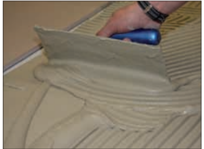
2 Geschmeidiges Aufziehen des Kammbettes des fließfähigen Sopro FKM XL.
