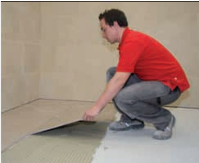
3 Großformatiges Feinsteinzeug unter Druck einlegen und justieren. Fugennetz vor der Erhärtung auskratzen.
