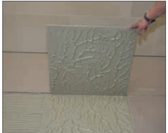
4 Optimale, nahezu hohlraumfreie Verlegung mit Sopro FKM XL möglich.
